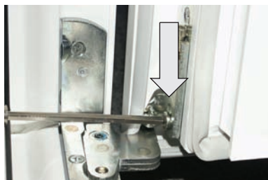
Anpressdruckverstellung mit Inbusschlüssel SW4.
