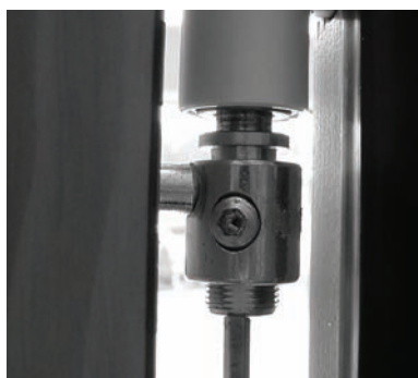
Höhenteller durch Drehung nach rechts bzw. links in gewünschte Position bringen, die restlichen Bänder ebenfalls nachkorrigieren.
