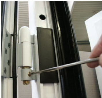
Fixierschraube lösen.
