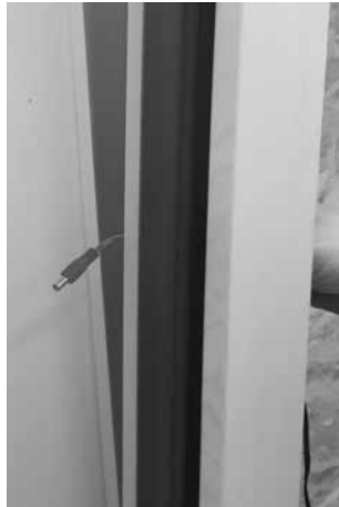
2. Stecker durch gekipptes Fenster nach außen führen
