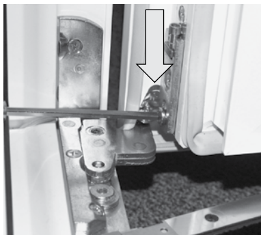
Anpressdruckverstellung mit Inbusschlüssel SW4.
