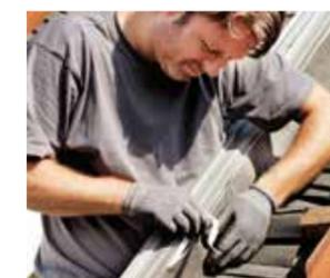
Einsetzen des neuen Fensterstocks und wetterfeste Einbindung mittels Unterdachshürze.
