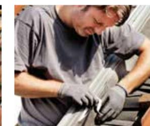
Einsetzen des neuen Fensterstocks und wetterfeste Einbindung mittels Unterdachschürze.
